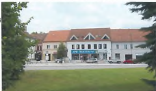
Obr. 8: Zastávka autobusu ve východní části náměstí
