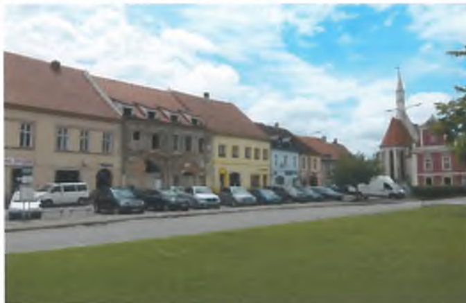
Obr. 6: Z pásu trávníku na jižní straně bude vytvořena jedna řada šikmých stání
